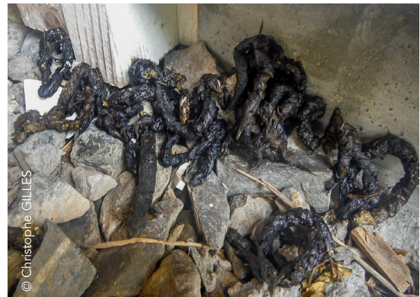
Un crottoir situé au niveau d'une ouverture sous le chalet nordique.
